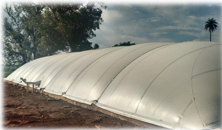
Figura 7. Biodigestor destinado aos dejetos da suinocultura. Fonte Própria.
