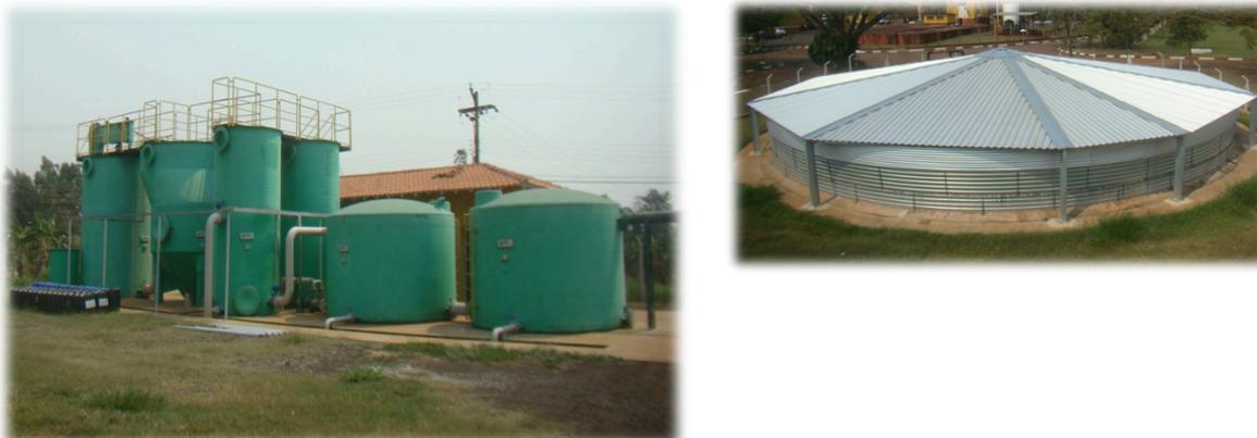
Figura 4. Estação de tratamento de água 2 – ETA 2 e reservatório do tipo australiano.
